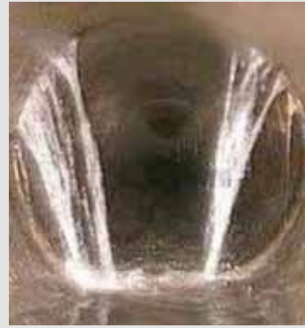
Grundwassereintritt Sauberes Wasser wird in der Abwasser- reinigungsanlage gereinigt.
